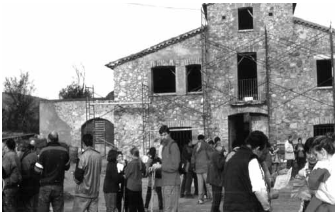
Caminada conjunta davant de Can Jornet - Es pot veure l'avançament de les obres de reforma de la façana.
