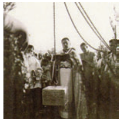
Col·locació de la primera pedra. 14/09/1947
