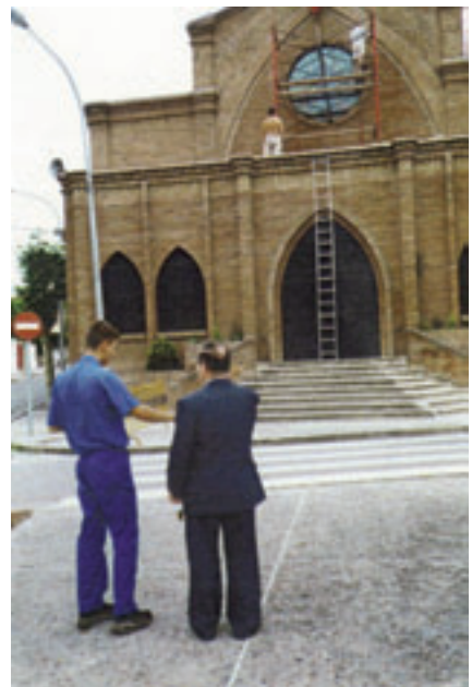
Instal·lació del rossetó de la façana (2001)
