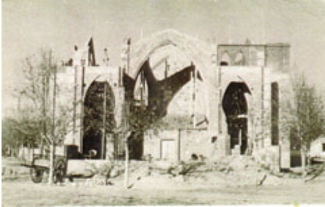
Construcció del temple
